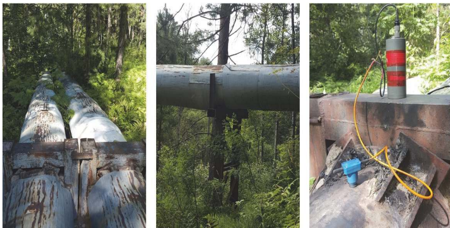
Рис. 8. Участок трубопровода с жестким креплением труб к опоре ( а ); трубы, уложенные на стойку без жесткого крепления ( б ); регистратор, установленный на трубе геофоном ( в )
